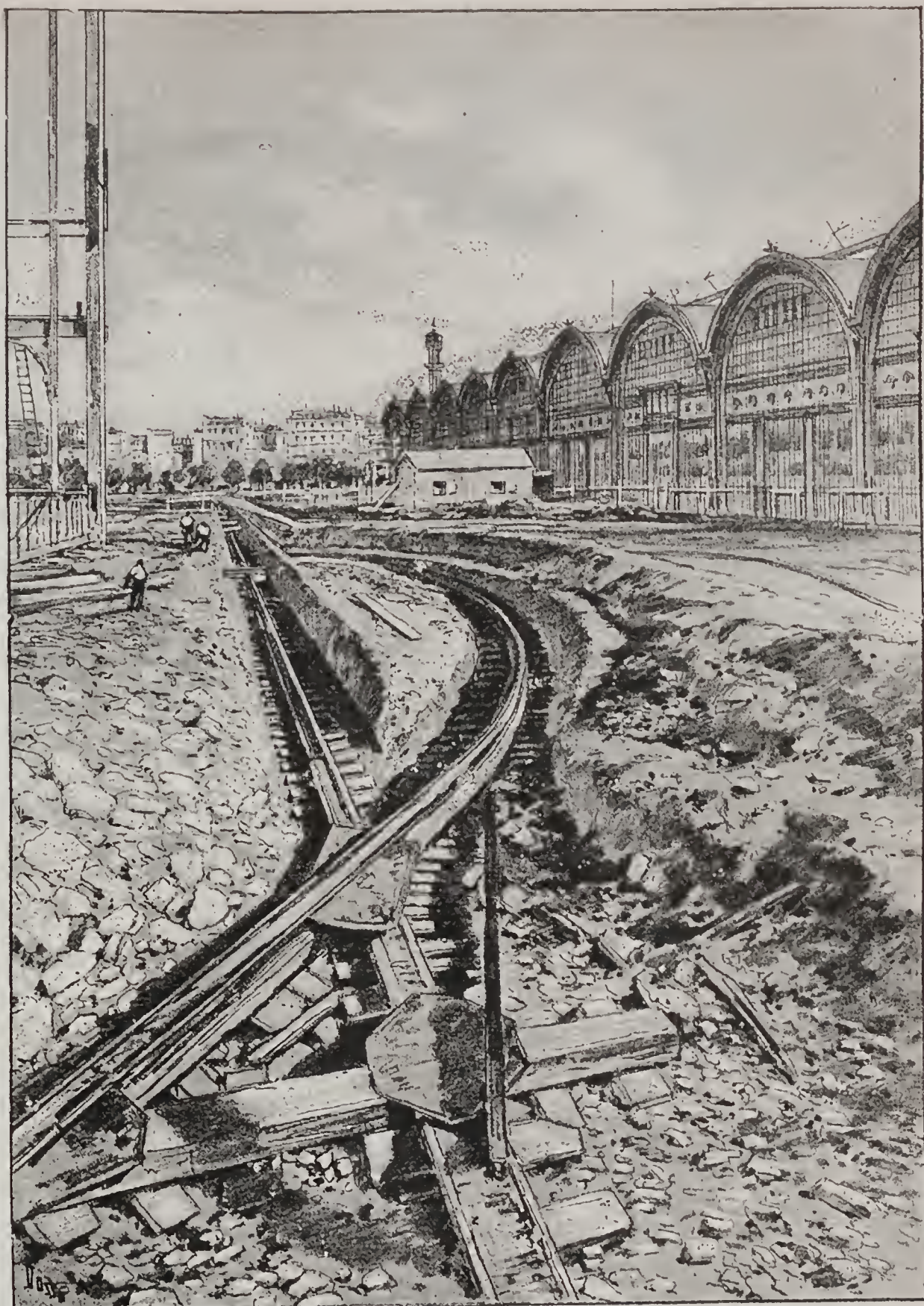
DÉPLACEMENT DE LA GALERIE DE 30 MÈTRES. — La voie tournante et son raccord.
